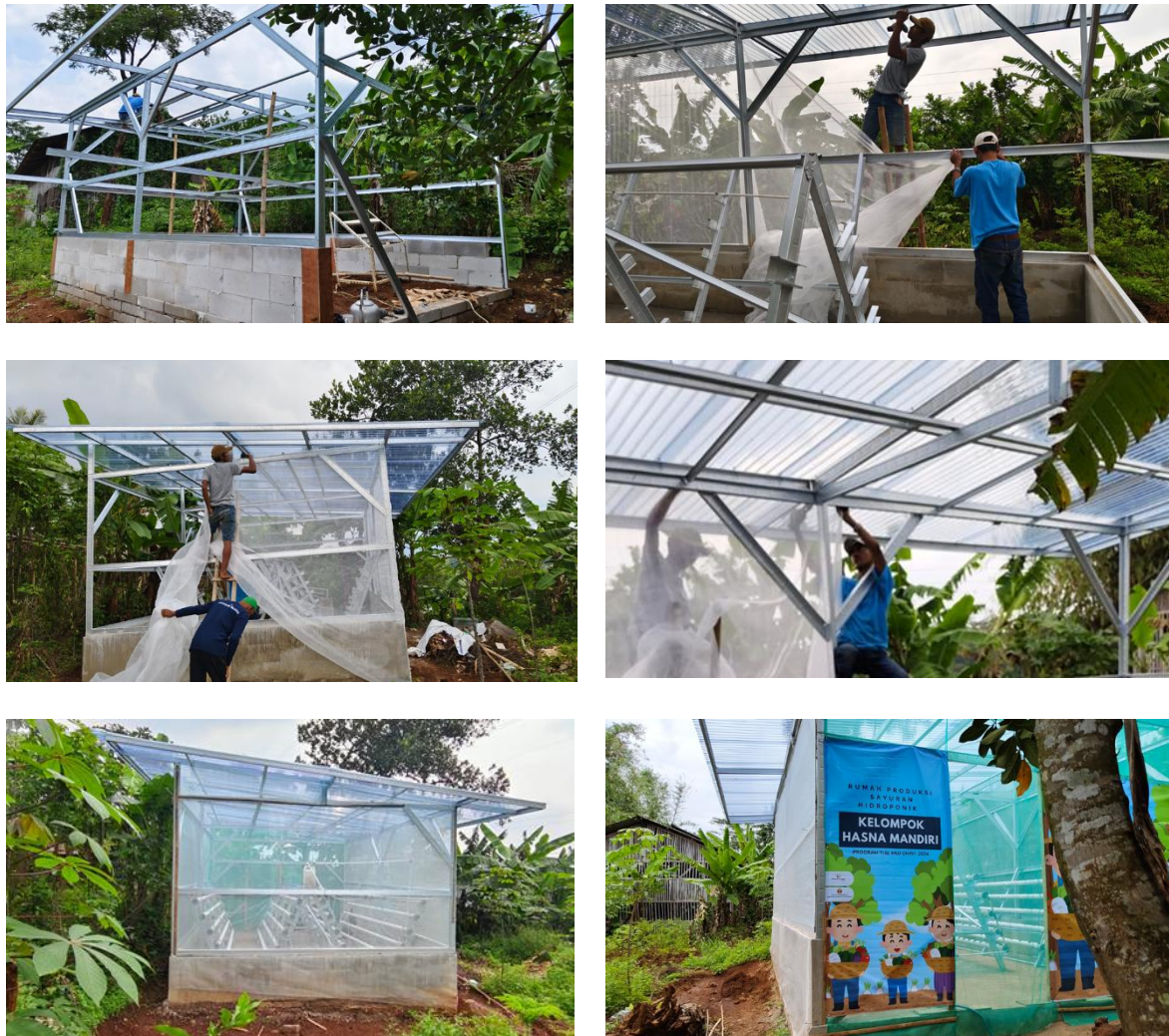
Gambar 1. Pembuatan rumah produksi hidroponik Kelompok Hasna Mandiri
