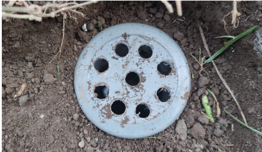
Gambar 3. Lubang Biopori yang sudah selesai di kerjakan
