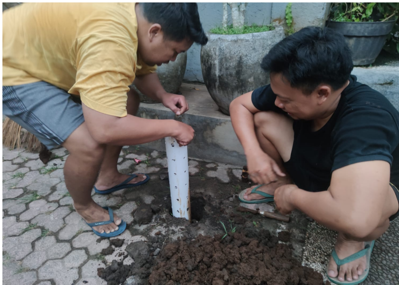
Gambar 2. Pembuatan Lubang Biopori di Pekarangan Rumah Masyarakat
