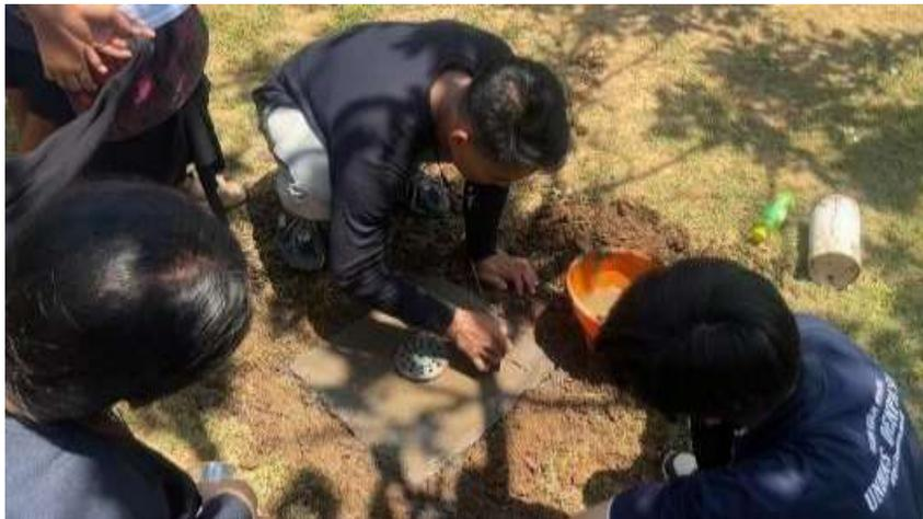
*Gambar 2. Pemasangan biopori*
