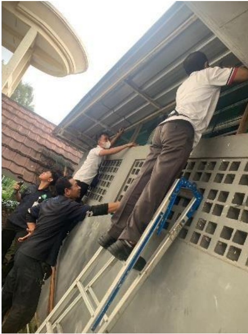
Gambar 5. Pemeriksaan kebocoran pipa di unit gizi
