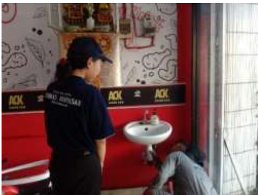
Gambar 1. Perbaikan keran air
