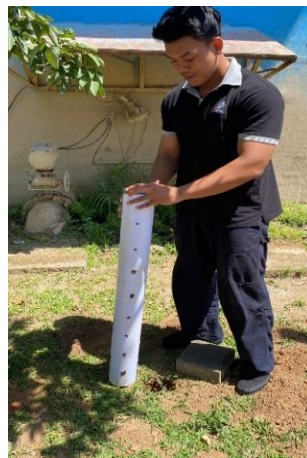
Gambar 2. Pembuatan Lubang Biopori Solusi Pengelolaan Sampah Organik
