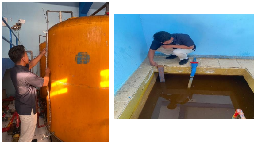
Gambar 1. Pembuatan Alat Ukur Tangki Penampungan Bahan Kimia Penggantian Alat Ukur Bak Campuran Bahan Kimia
