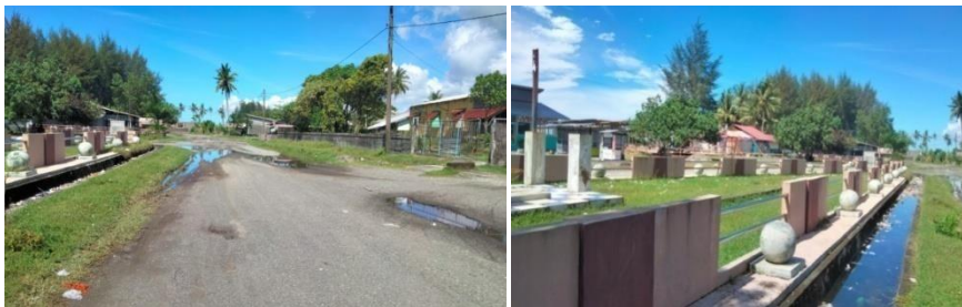
Gambar 3. Kondisi jalan menuju lokasi wisata Kupiah Meukutop dan Pantai Batee Puteh
