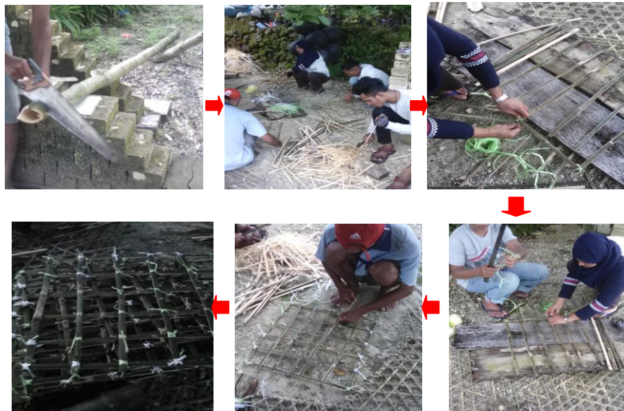
Gambar 2. Proses Pembuatan Frame
