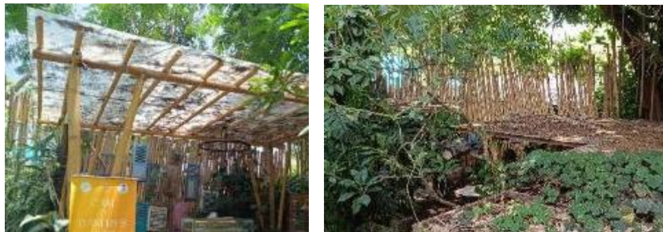
Gambar 5. Penggunaan material bambu pada bangunan Bron Urban Cafe (sebagai struktur bangunan dan dinding pembatas lahan)
