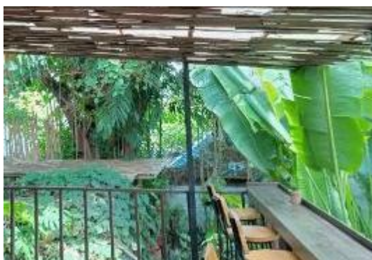
Gambar 7. Material Baja Ringan ( Hollow ) sebagai Rangka Kanopi
