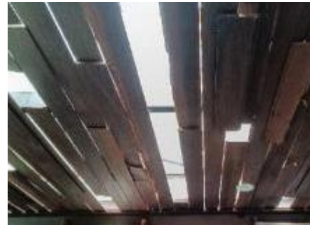
Gambar 8. Polycarbonate sebagai Atap (untuk menyalurkan Cahaya Alami)
