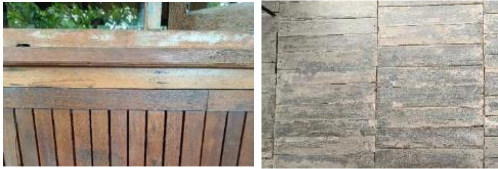
Gambar 4. Material kayu pada bangunan Bron Urban Cafe (digunakan pada bagian dinding dan lantai)
