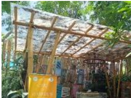
Gambar 8. Polycarbonate sebagai Atap (untuk menyalurkan Cahaya Alami)
