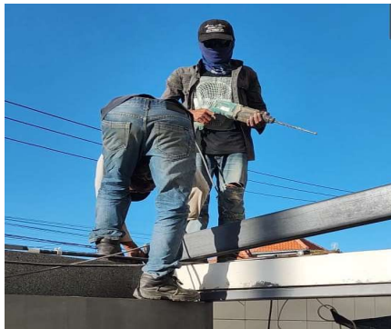
Gambar 5. Proses Pemasangan Rangka Struktur Atap TPS
