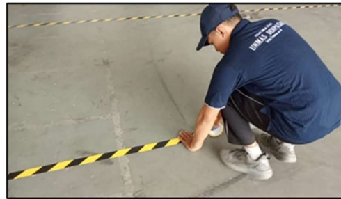
Gambar 2. Pembuatan sekat marka parkir
