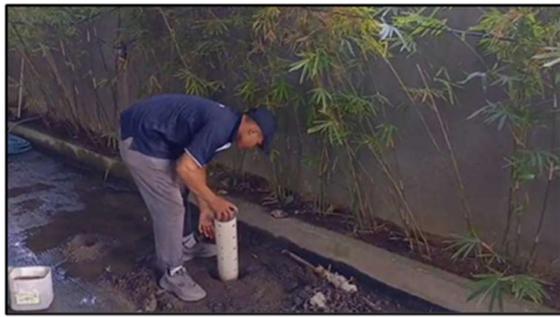
Gambar 1. Pembuatan lubang biopori
