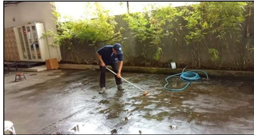
Gambar 3. Pelaksanaan Perawatan beton dari lumut
