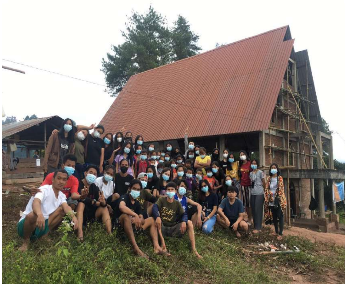
Gambar 2. Renovasi Gedung Gereja
