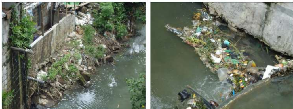
Gambar 4. Kondisi eksisting saluran drainase yang dicemari air limbah domestik dan sampah
