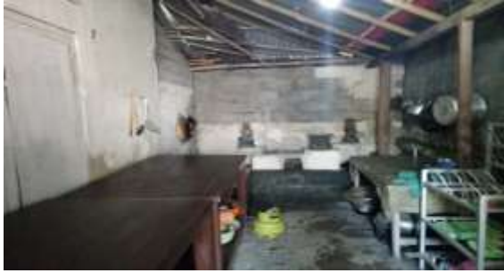
Foto 2. Kondisi Meja dan Atap Dapur setelah Perbaikan (Dokumentasi Tim, 2017)
