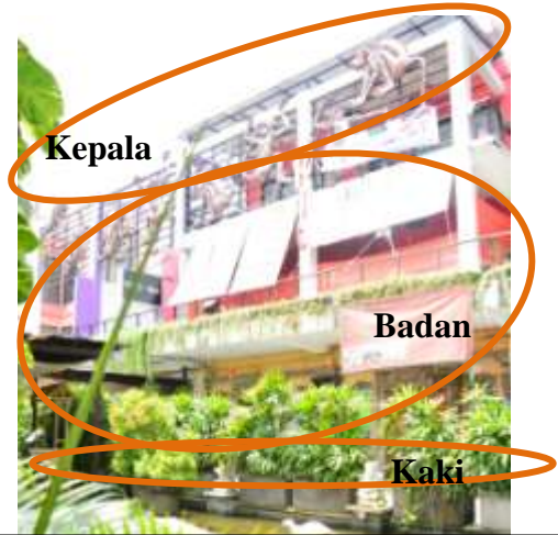
Gambar 4.13: menggunakan gaya arsitektur ekspresionist dan modern yang dapat dilihat dari penggunaan ornamen berupa patung yang ditempel pada reiling besi hollow, penggunaan warna yang mencolok. Gaya modern dapat dilihat dari bentuk dasar bangunan yang sederhana dan cenderung berbentuk kotak. Sumber : Dokumentasi Penulis, 2017
