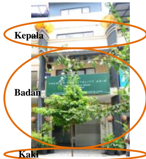
Gambar 4.17: menggunakan gaya arsitektur ekspresionist dan modern yang dapat dilihat dari penggunaan ornamen pada kolom bangunan, penggunaan warna yang mencolok. Gaya modern dapat dilihat dari bentuk dasar bangunan yang sederhana dan cenderung berbentuk kotak. Sumber : Dokumentasi Penulis, 2017
